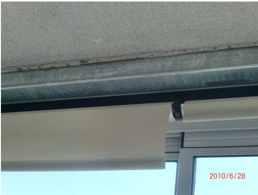
Bild 4. Ljudisoleringen är svag i kontakten mellan ovanliggande balkonger. Se vidare under avsnitt 5 (Gaffeln)
